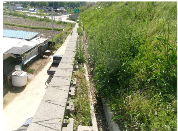
상부 배수로 전경
