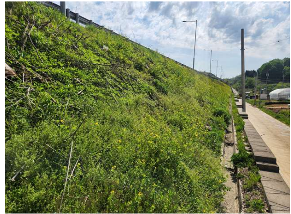
상부 성토부 전경
